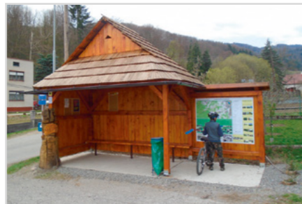
Drevená zastávka a oddychové miesto v Malachove Haltestelle in Holzausführung und Rastplatz in Malachov
